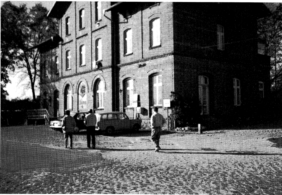
Woldegk – Bahnhofsgebäude, Stadtseite
