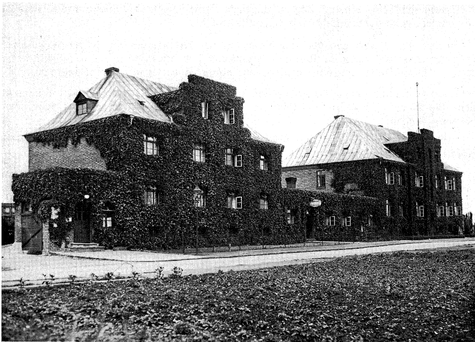
Seegrenzschlachthaus Wismar, Verwaltungsgebäude mit Casino an der Kopenhagener Straße.
