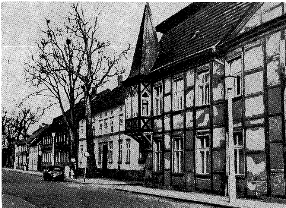
Das von Herzog Adolf Friedrich IV. (Dörchläuchting) 1780 in Neubrandenburg erbaute Komödienhaus
